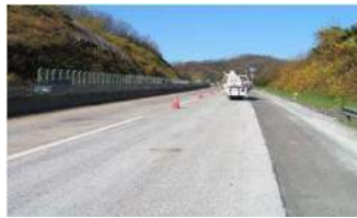
Mài mặt đường
