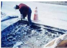
Sửa chữa nền
