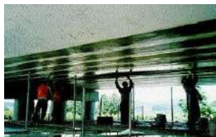
Gia cường cốt thép bản mặt cầu
