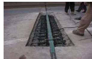
Sửa chữa mối nối bù
