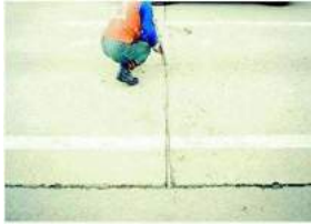
Sửa chữa mối nối
