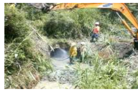
Cống thoát nước
